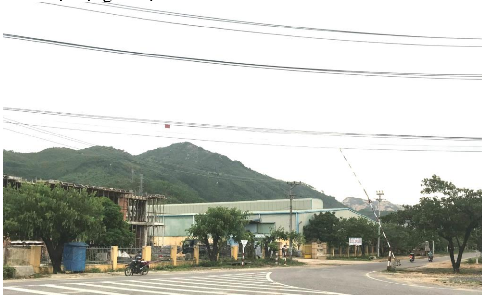
(Công trình nhà máy sản xuất trong KCN)
