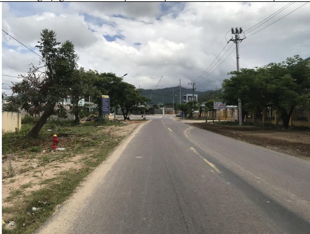
(Hiện trạng đường Trung tâm, đoạn từ đường ĐT638 đến đường số 23)
