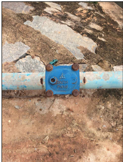
HIỆN TRẠNG ĐƯỜNG CẤP NƯỚC
