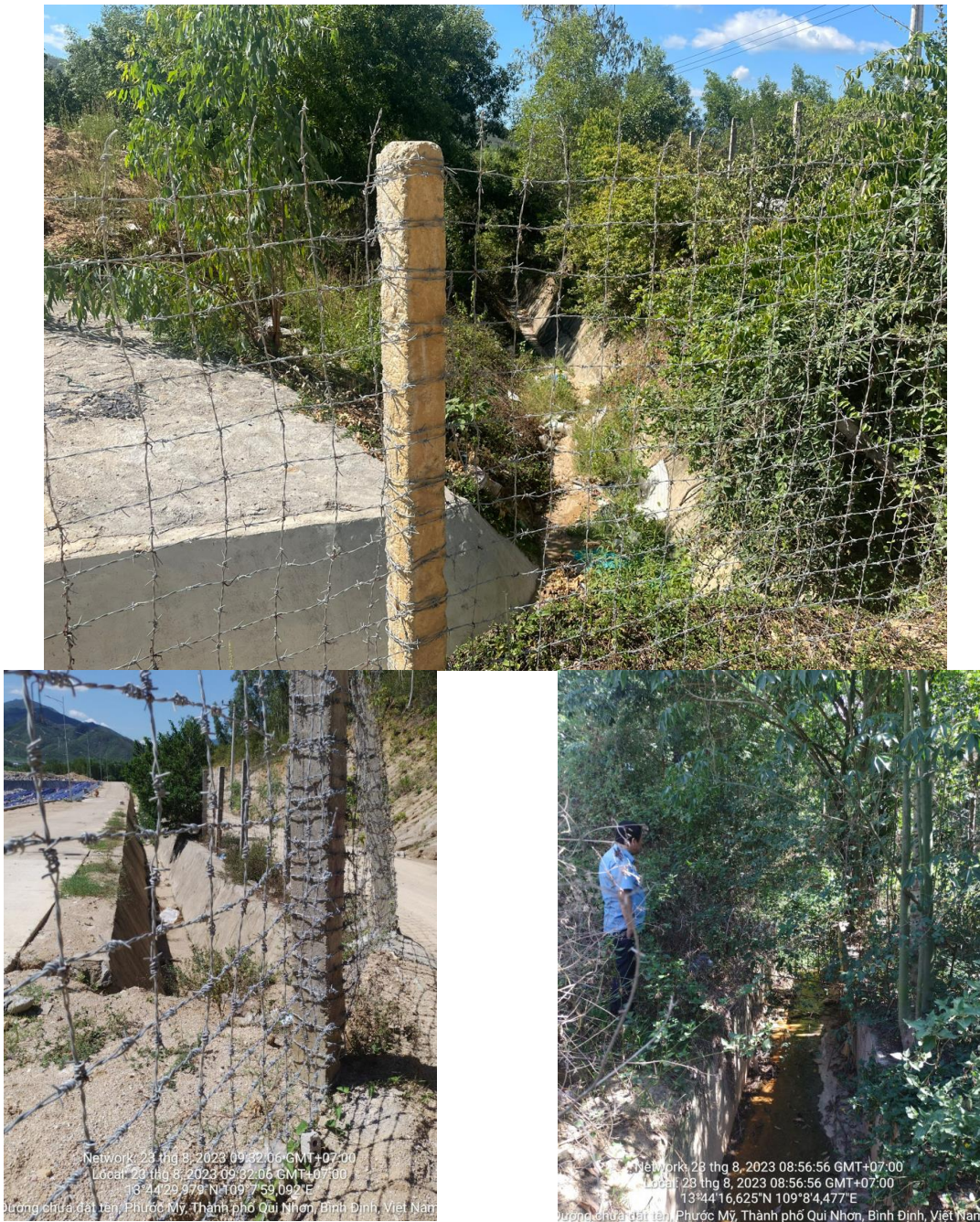
Hình 2.8. Mương thoát nước phía Tây – Tây Nam hiện hữu
