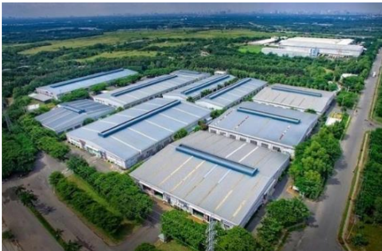
(Cụm công nghiệp Bình An – thuộc xã Phước Thành)
