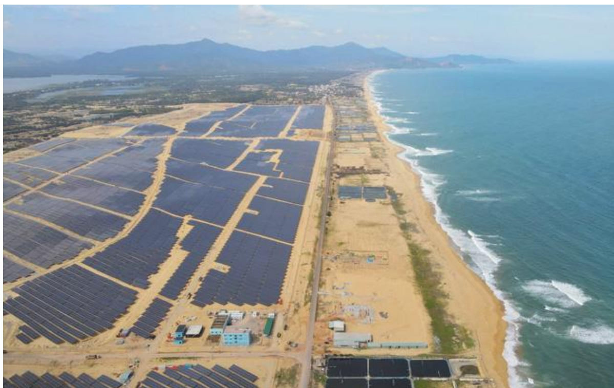
Hình 18: Nhà máy điện mặt trời Phù Mỹ
